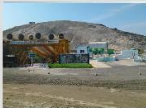
ROCK CAVERN PROJECT (HCC) PADUR (UDIP) KARNATAKA 1MLD WWTP
